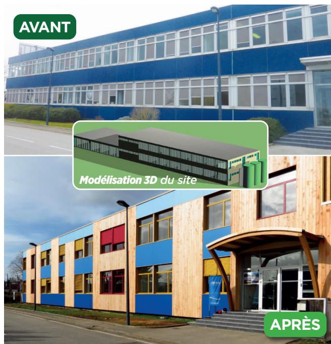
Rénovation énergétique du bâtiment tertiaire du parc des Rives de l'Oise 1500 m 2 pour l'ARC Compiègne
