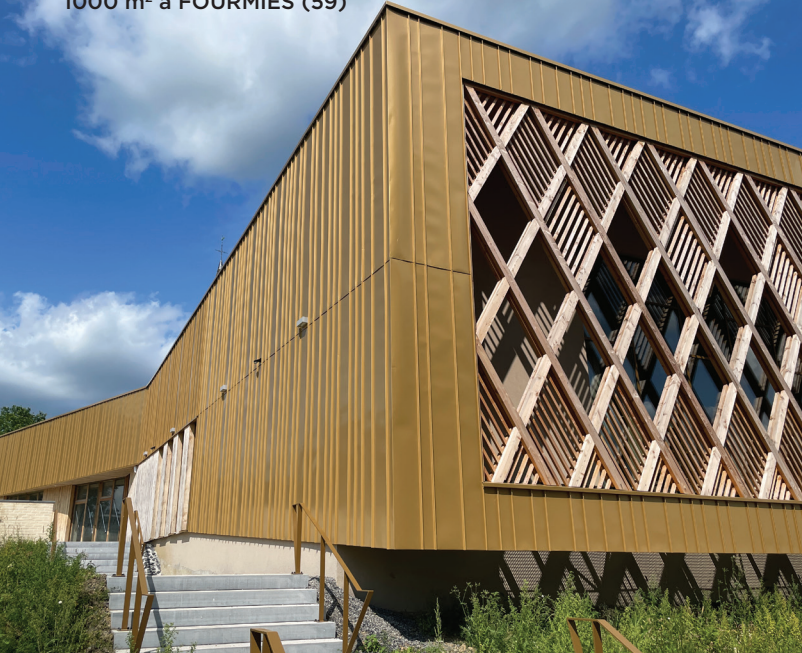
Certification Passivhaus de la salle polyvalente en bottes de paille 1000 m 2 à FOURMIES (59)
